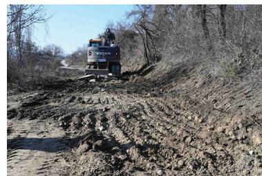
Ј.П. КОМУНАЛЕЦ КАВАДАРЦИ ПРОДОЛЖУВА СО РЕАЛИЗАЦИЈА НА СВОЈАТА ПРОГРАМА. СЕ РАБОТЕШЕ НА КОМПЛЕТНА РЕКОНСТРУКЦИЈА НА ЧЕТВРТИОТ ОБЈЕКТ НА УЛ. „ЦРНОРЕЧКА“ КОЈА ОПФАКАШЕ РЕКОНСТРУКЦИЈА НА ВОДОВОДНАТА ЛИНИЈА СО ПЕ ЦРЕВО Ф63 И КОМПЛЕТНИ ПРИКЛУЧОЦИ ДО БРОИЛОТО.
